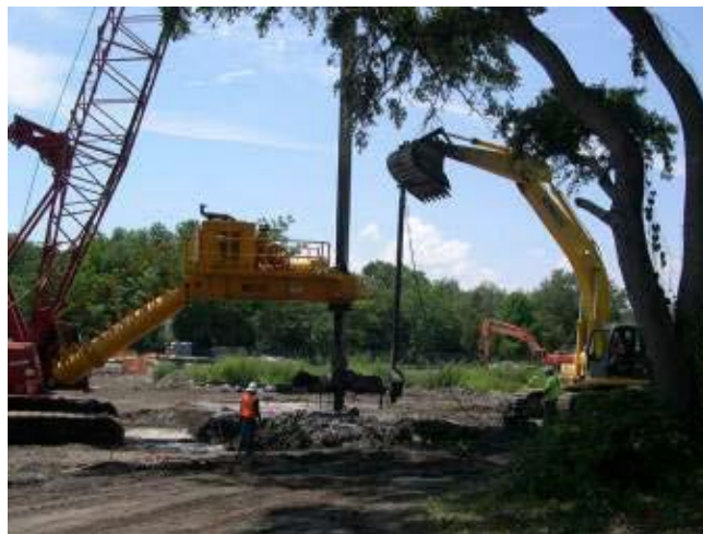
图 7-4 特制的探测取样设备（取样评估混合是否均匀和边界是否重合）
