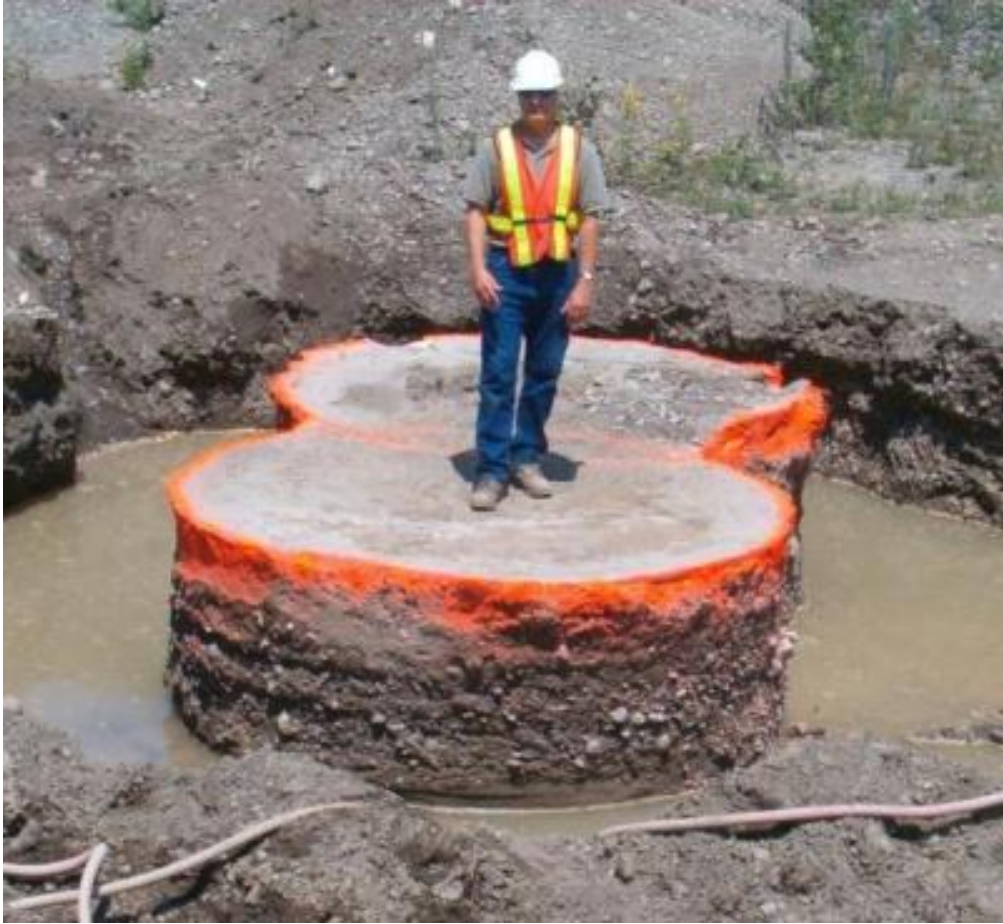
图 7-5 剖挖后观察原位固化/稳定化处理单元边界是否重合的举例说明
